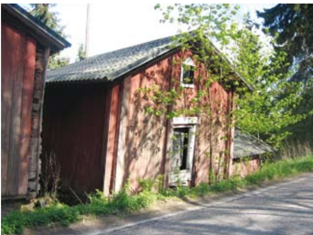
Tienpinta kohoaa ja puut hiipivät aitan kylkeen - aitta kärsii. Onneksi katto on suojattu. Hirsirakennusta on helppo korjata, jos toimeen tartutaan.
