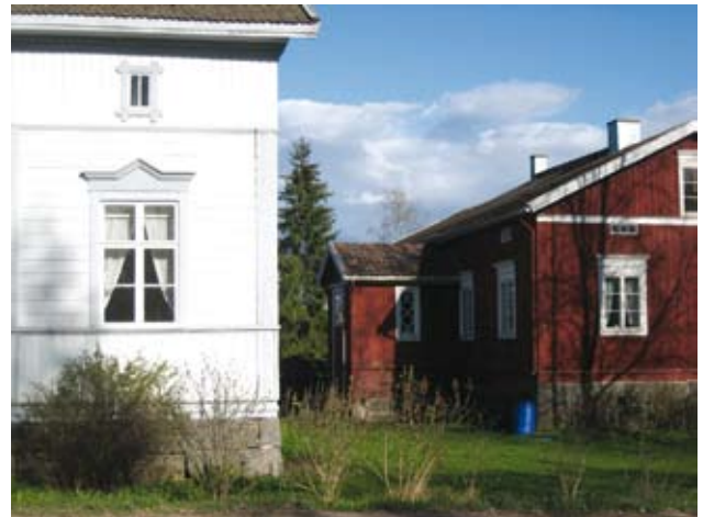
Kaksi aikakautta! Vanha rakennus: punamullattu pystyлаudoitus, perinteiset ikkunat. Uusi: koristeelliset ikkunat ja vuoraus. Manttaali, Riihikoski, Pöytyä.
